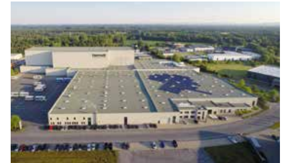
Usine III de Hövelhof, Allemagne
