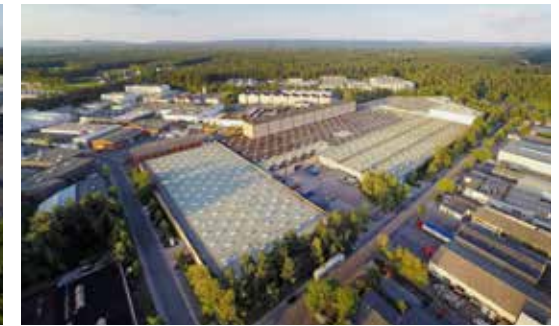
Usine II de Hövelhof, Allemagne
