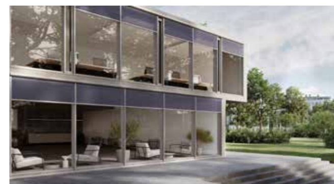
Montáž na fasádu
