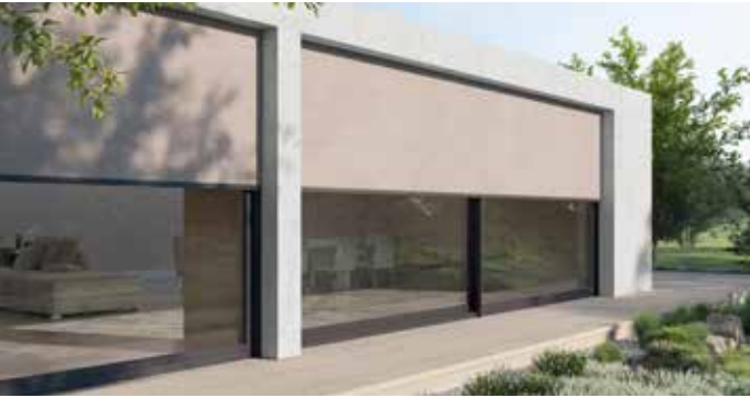
Montaż w nadprożu
