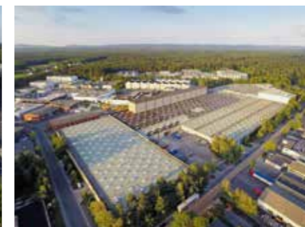
Usine II de Hövelhof, Allemagne
