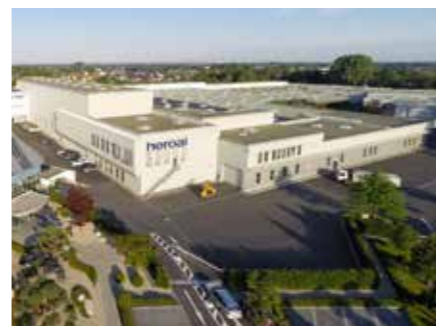
Usine I de Verl, Allemagne
