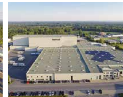
Usine III de Hövelhof, Allemagne
