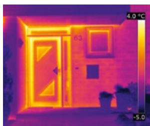
Před rekonstrukcí – červená barva označuje vysoké ztráty energií
